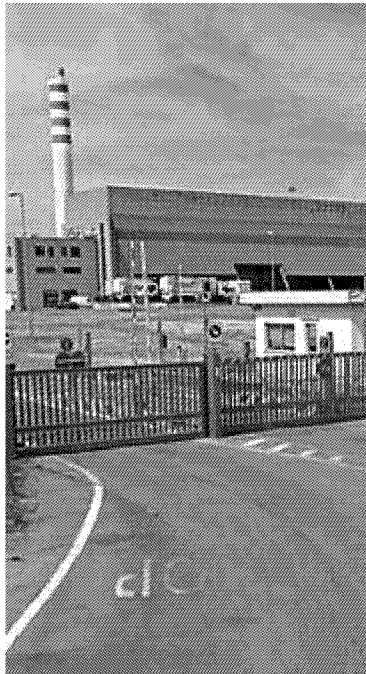
TERMOVALORIZZATORE L'impianto a San Zeno
